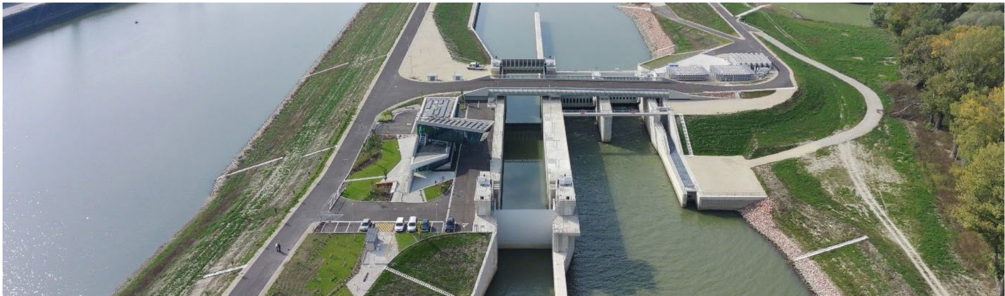
河口水位控制结构和水闸
