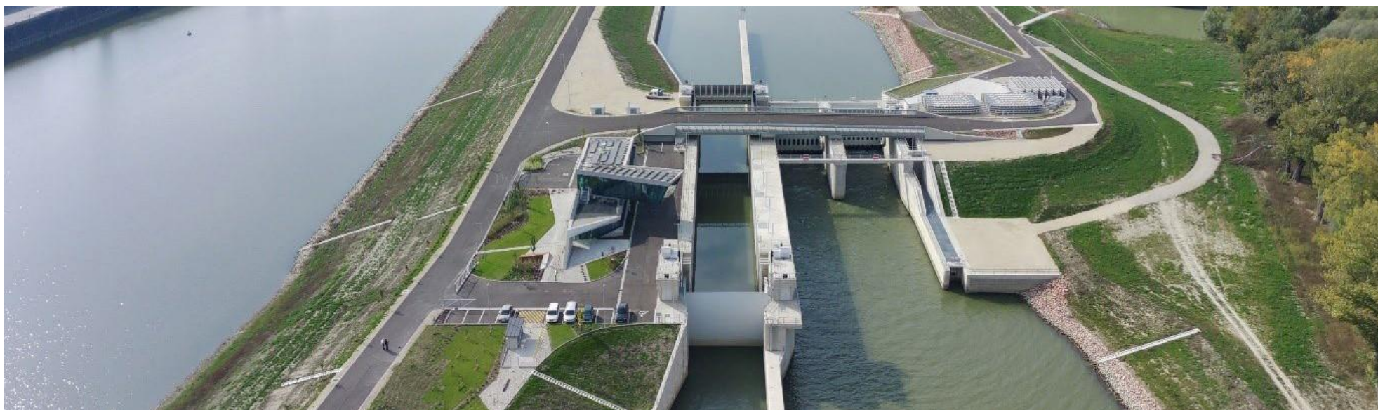
河口水位制御構造および閘門
